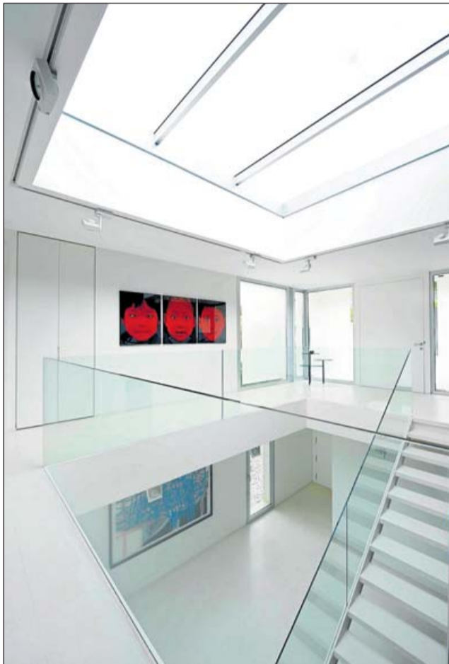
VESTÍBULO. Predominio del cristal y la luz. El lucernario, las barandillas de cristal y las escaleras sin corta huella aumentan la ligereza espacial y visual.
